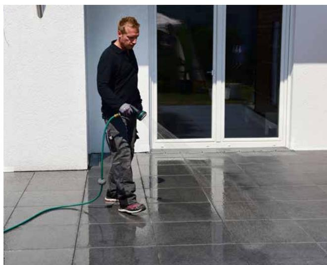
10 Avant jointoiment, mouiller la surface à saturation et la maintenir humide.
