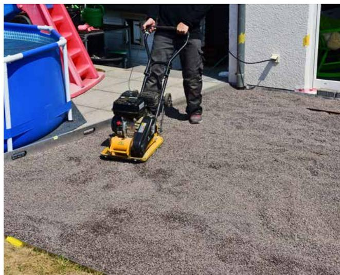
**1** La construction doit être dotée d'un encadrement robuste, porteur, sur toute la périphérie (p.ex. pierres de bordures réalisées avec le Mortier rapide Sopro Rapidur® M8). La couche de gravier garantit la résistance au gel. Elle doit présenter une épaisseur de 30 cm au minimum, compactée couche par couche pour éviter un tassement dans la zone concernée. Elle doit avoir une inclinaison suffisante.
