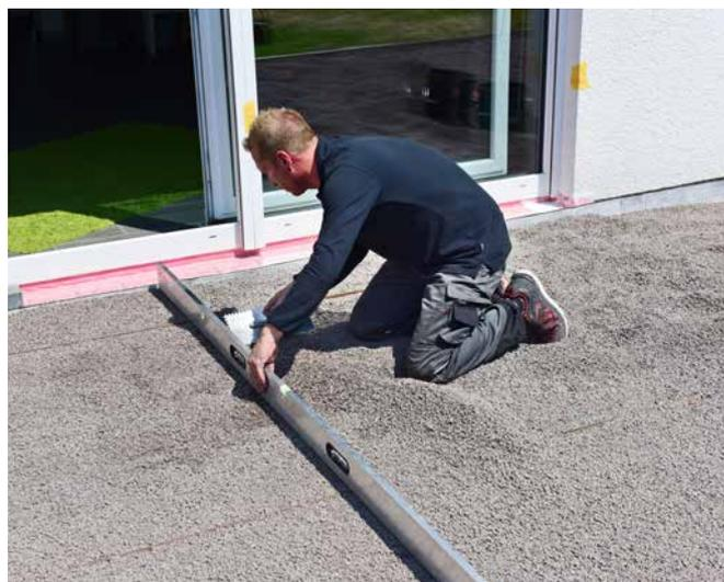
**3** L'épaisseur de la couche porteuse et la formation d'une inclinaison de 1,5 % au minimum doivent être régulièrement contrôlés.
